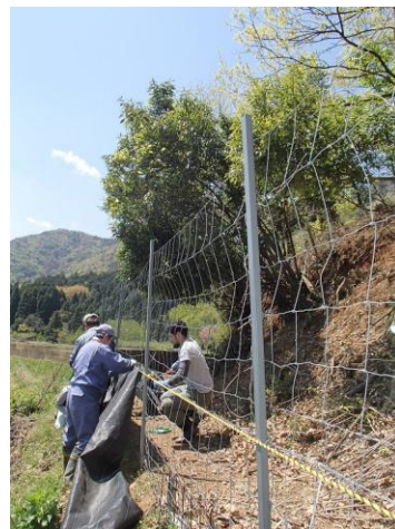
獣害対策フェンス修繕
